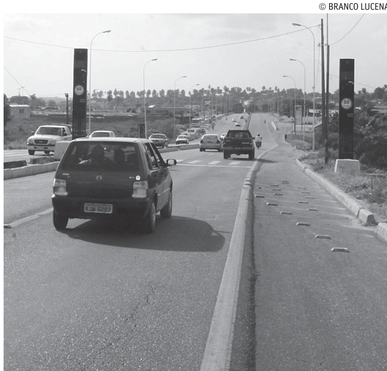
A instalação das novas lombadas vai controlar o excesso de velocidade
